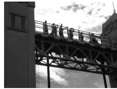
<伏見:三栖閘門>
