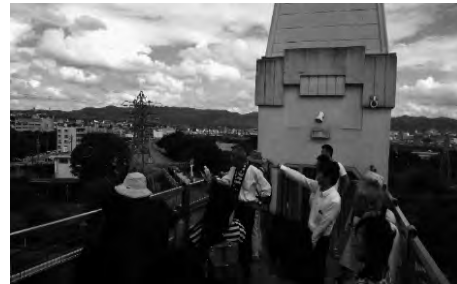
<伏見:三栖閘門>
