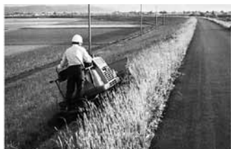
堤防除草作業
